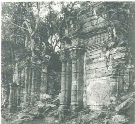
Fasada kościoła św. Ignacego
